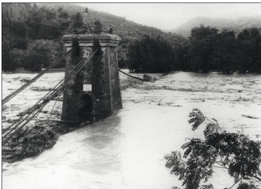
Figura 2. Palanca de la Colònia Sedó destruïda per l'aiguat del 20 de setembre de 1971
